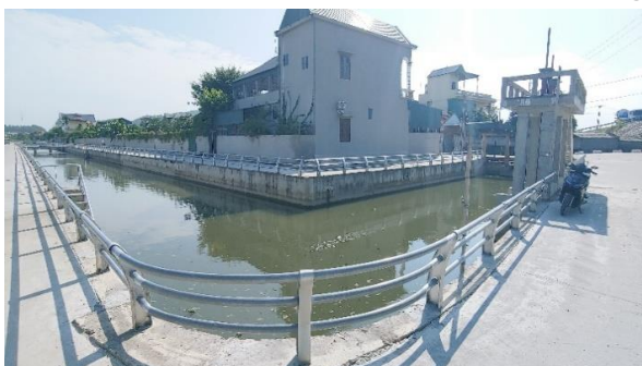
(Đầu tuyến kênh - Công ĐT ông Thành)
