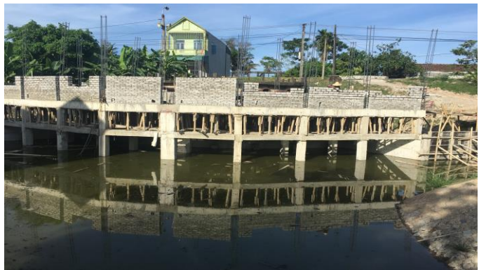
Thi công sàn đặt động cơ điện
