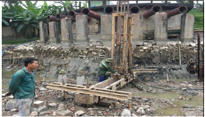
Ép cọc hố móng
