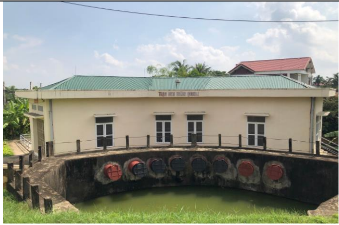
Chính diện bể xả
