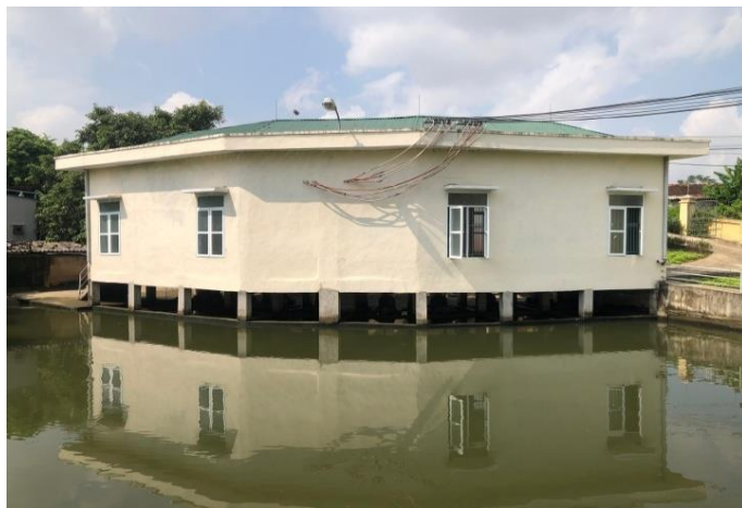
Chính diện bể hút
