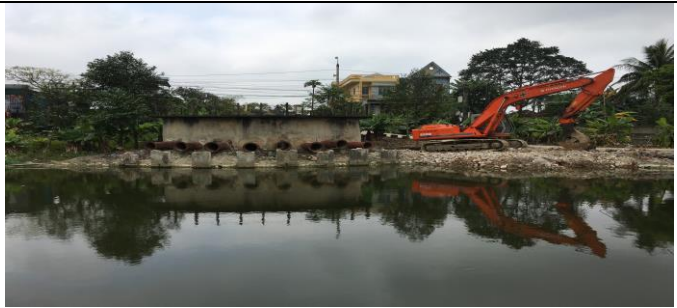
Phà dỡ công trình cũ
