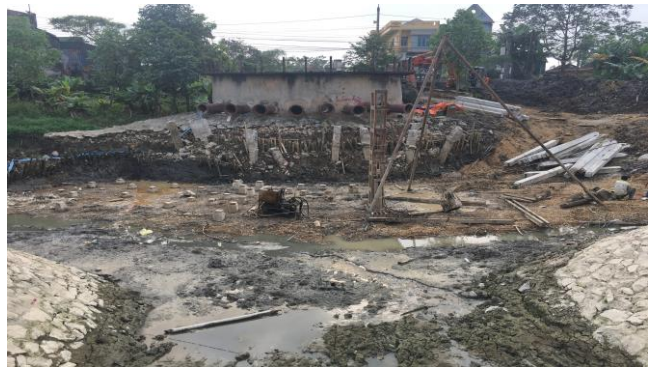
Ép cọc móng trạm bơm
