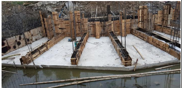
Móng nhà trạm
