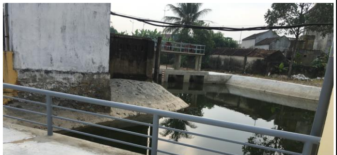
Bể hút trạm bơm
