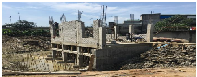
Thi công sàn đặt động cơ
