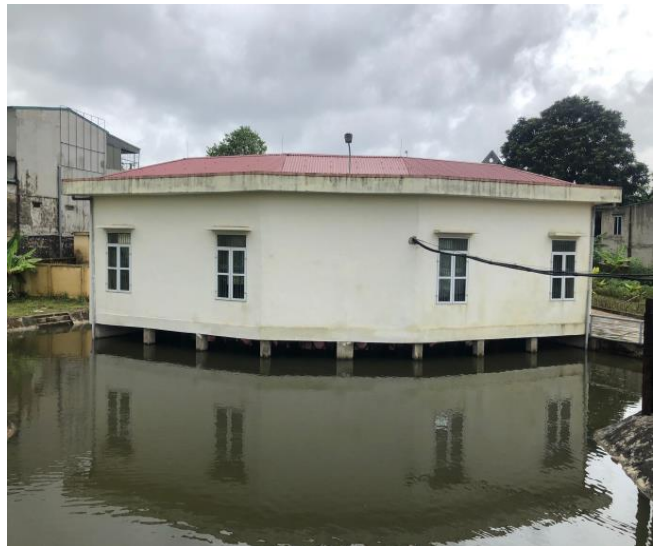
Chính diện bể hút
